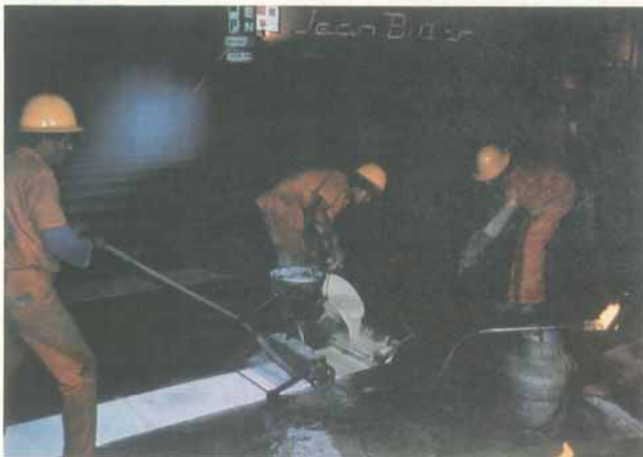
MASSA TERMOPLÁSTICA APLICADA POR EXTRUSÃO
