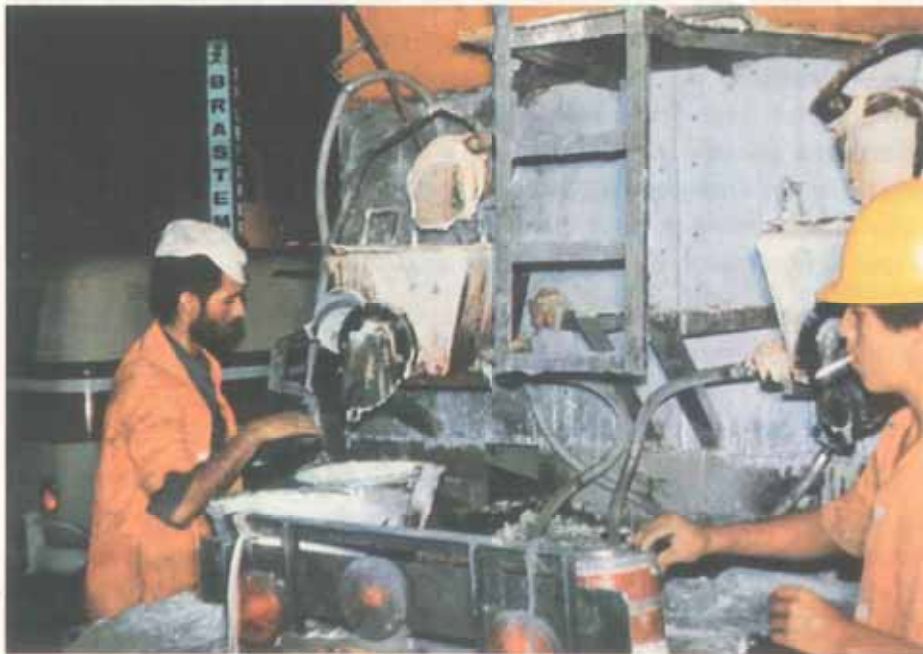
EQUIPAMENTO DE APLICAÇÃO DO TERMOPLÁSTICO EXTRUDADO.
